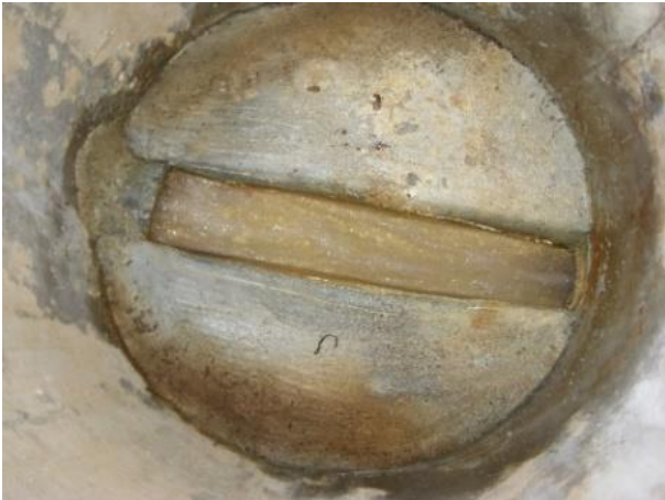
Bild 10: Offenes Gerinne Kontrollschacht
