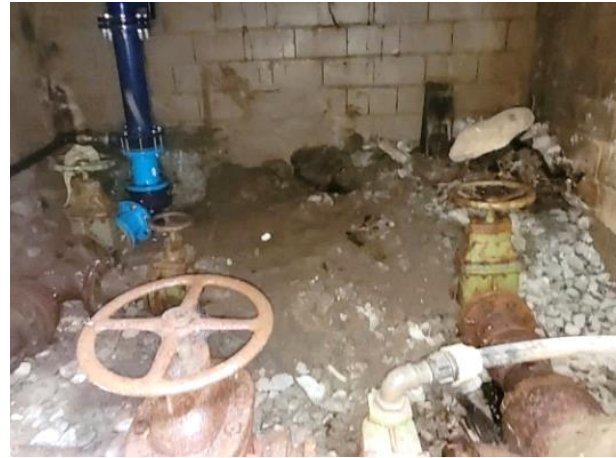
Bild 13: Schacht 3005 vor der Sanierung
