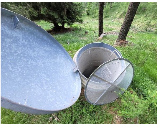
Bild 8: Einstieg mit Pilzdeckel
