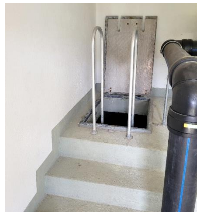
Bild 2: Einstieg in Wasserkammer
