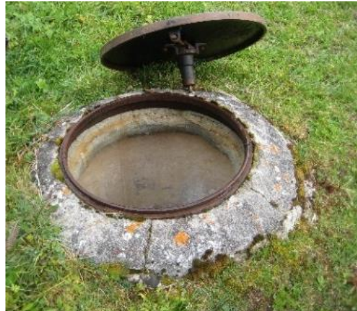
Bild 11: Kontrollschacht in Wiese
